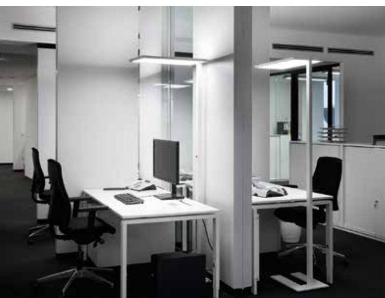
Abb.: Die Arbeitsplätze wurden mit der Stehleuchte »LED Around« und Präsenzmelder ausgestattet. Sogenannte »Schwarschaltungen« sind möglich und lassen sich zu einem Leuchten-Netzwerk verbinden.
