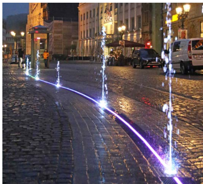
Abb.: Neun kleine Wasserfontänen sind durch das Lichtband verbunden und leuchten nach Einbruch der Dunkelheit in farbigem Licht.
