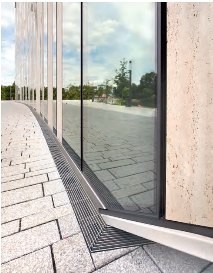
links: Fassadenrinne FR-10K komplett aus Edelstahl
